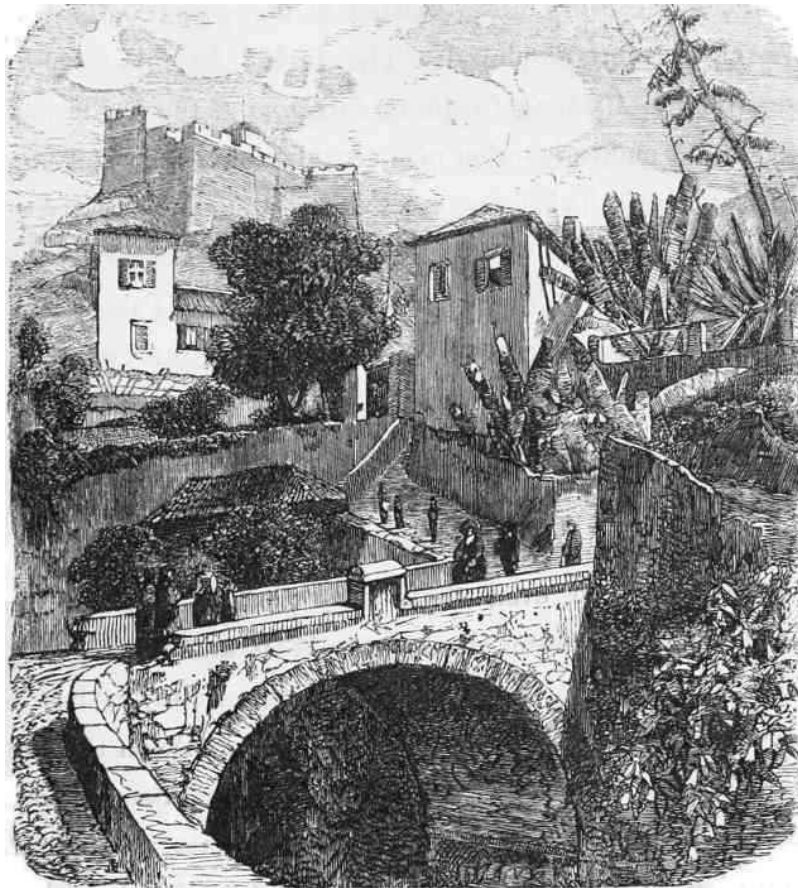
BRIDGE OVER THE RIBEIRO SECO.
