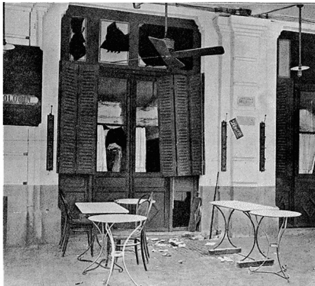
La terrasse du café de Hanoï-Hôtel après l'explosion de la bombe.
