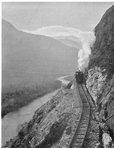
Un tournant de la ligne près de Brigue, au-dessus du Rhône.
