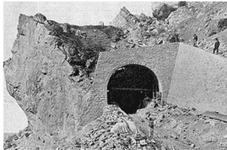
Tunnel Victoria, sur la rampe sud (côté de Brigue). Le profil du rocher rappelle celui de la feue reine d'Angleterre.
