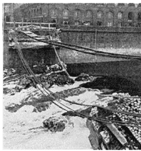
Après la chute du pont: seule la dernière pile émerge, tandis que les rails du tramway, les câbles électriques et les conduites d'eau relient toujours les deux rives.--Phot. Thuret.
