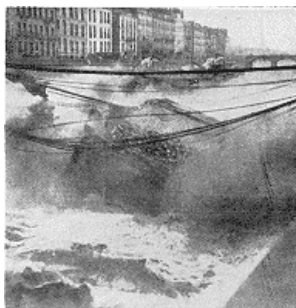
L'effondrement, dans la Loire, de la dernière pile, entraînant celui de tout l'ouvrage.--Phot. Girard.
