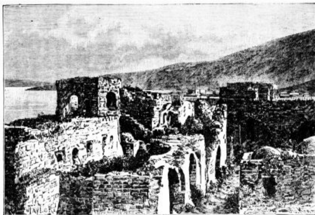
Constructions latines en terre sainte.—Château de Tancrede à Tibériade.
