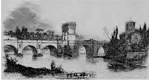
Saintes.--Arc de triomphe de Germanicus, récemment démoli.
