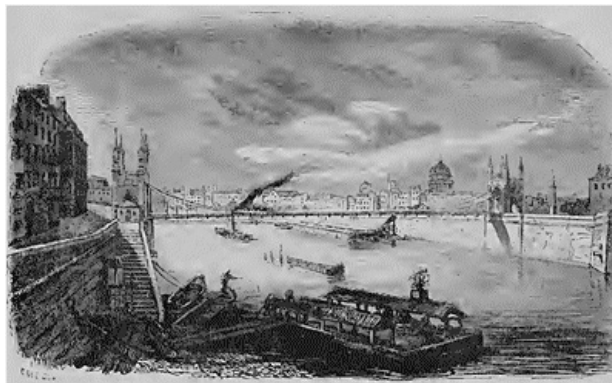
Pont de la Cité nouvellement construit entre la Cité et l'île Saint-Louis.
