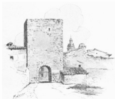
SALINILLAS DE BURADÓN Torre y puerta de las murallas.
