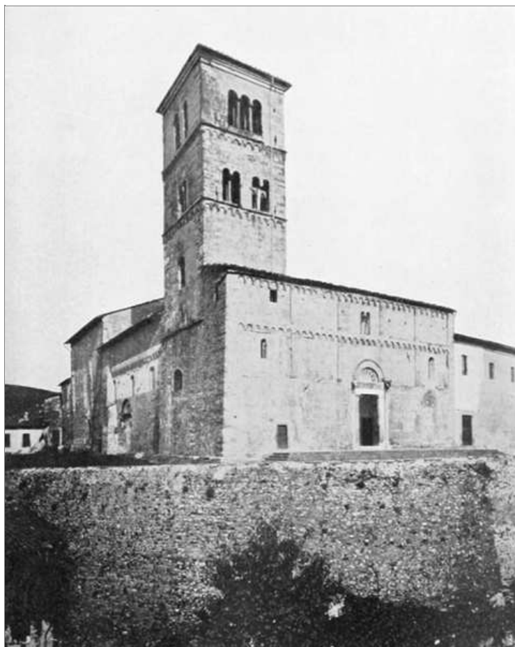
BARGA — IL DUOMO: LATO SUD ED OVEST CON GLI AMPLIAMENTI DEI SECC. XIII, XIV, XVII. (Fot. Magri).
