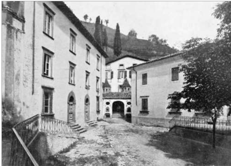
BAGNI DI LUCCA — STABILIMENTO DEL BAGNO ALLA VILLA. (Fot. Pellegrini).
