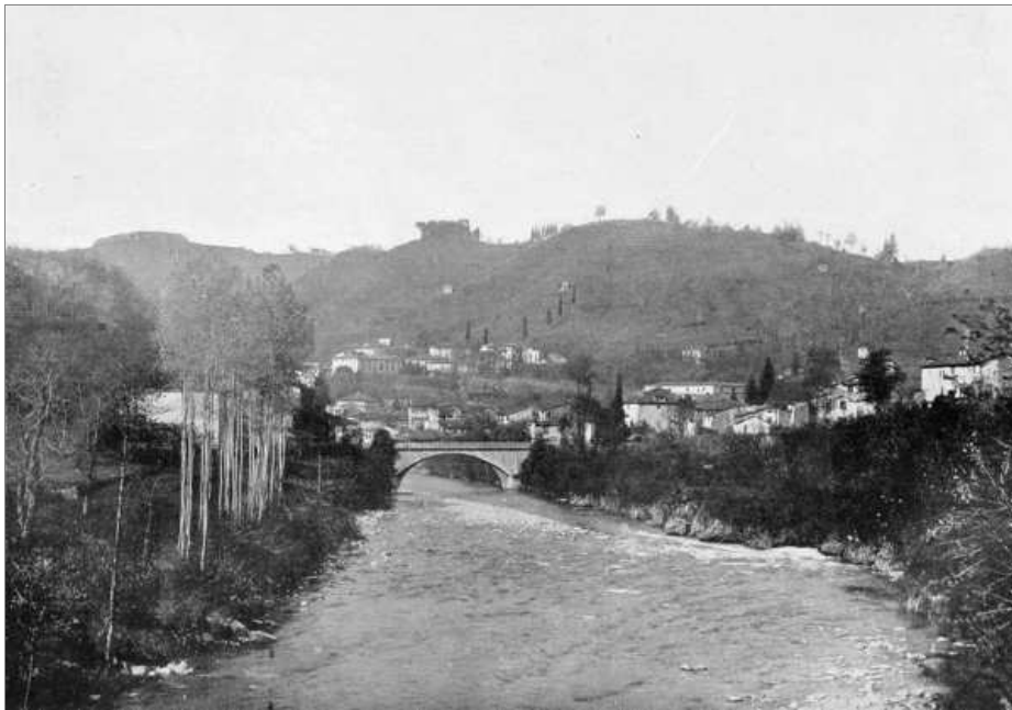
PONTE A MOCCO.
