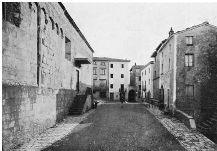
BENABBIO — PIAZZA E FIANCO DELLA CHIESA. (Fot. Pellegrini).
