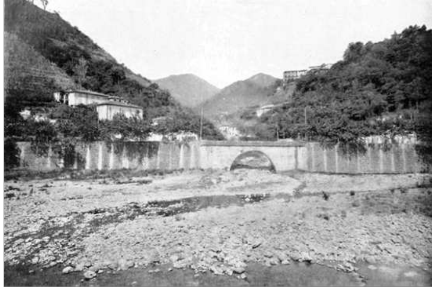
BAGNI DI LUCCA — TORRENTE LA LIMA COL PONTE CAMAJONE. (Fot. Brogi).
