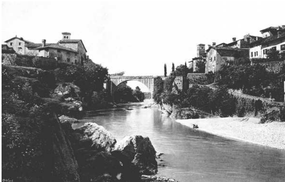
Cividale. Ponte del Diavolo, visto da nord.
