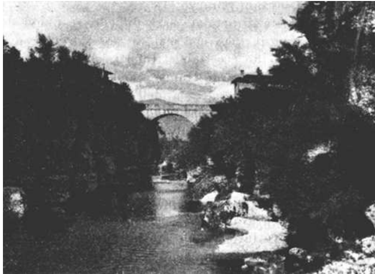
Fig. 18 a . — Lo storico ponte di S. Quirino.
