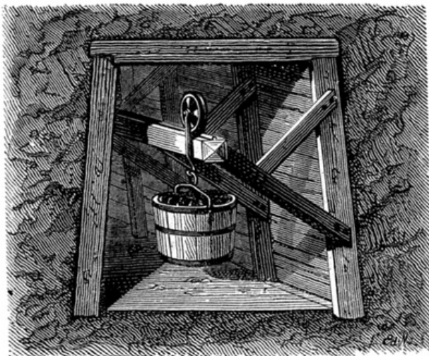
Fig. 73.—Chemin à la Palmer (dans une galerie de mine).
