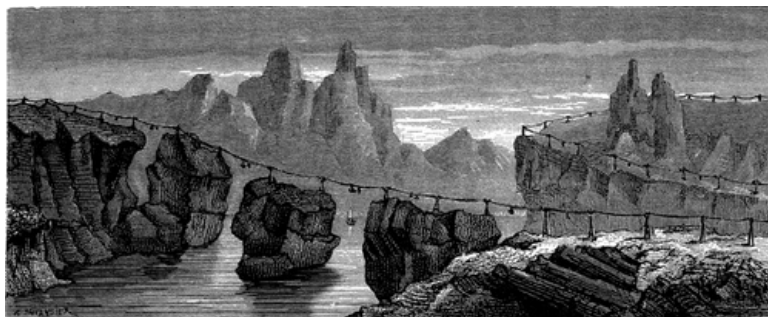
Fig. 74.—Transport par câble métallique (système Hodgson).
