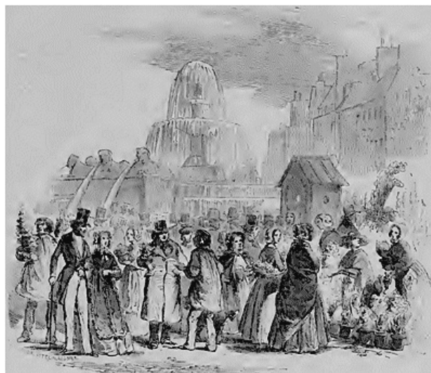
Vue du Marché aux fleurs du Château-d'Eau.
