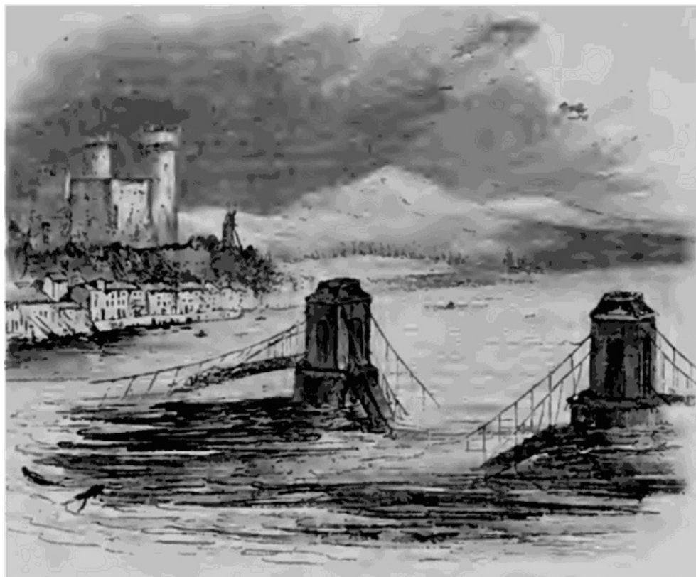
Vue du Pont de Beaucaire, emporté par un coup de vent.
