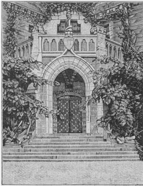
FIG. 2.—PRINCIPAL ENTRANCE TO THE CHÂTEAU D'ABBADIE.
