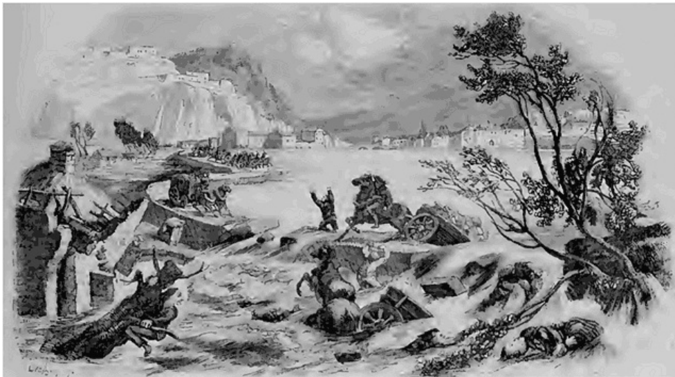
Rupture d'une Digue.
