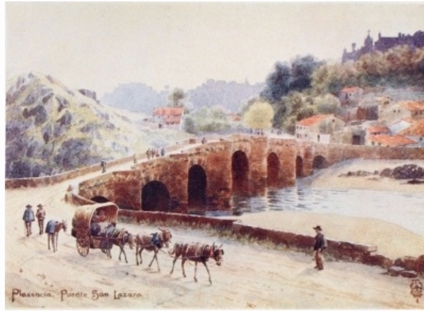
PLASÉNCIA Puente San Lazaro.
