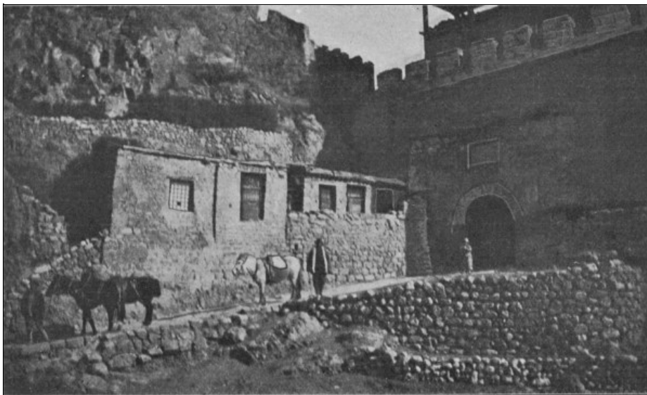
Kukwan an der grossen Mauer
