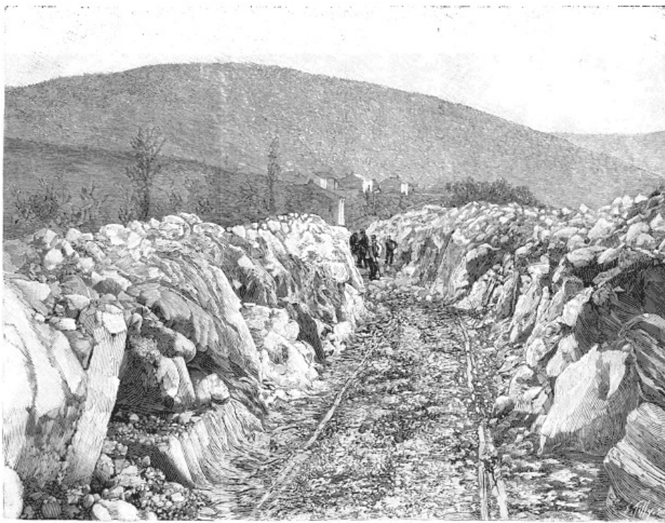
Tranchée ouverte dans les glaces pour déblayer la route des Hautes-Rivières à Thilay.--Phot. Ronsin.
