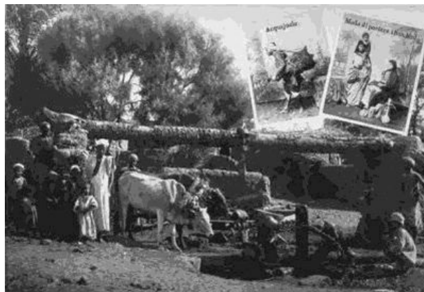
UNA SAKKIE ossia RUOTA A SECCHIE PER ESTRARRE L'ACQUA DAL NILO
