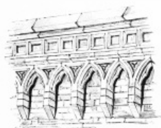
BRICK CORNICE—BROLETTO, BRESCIA.
