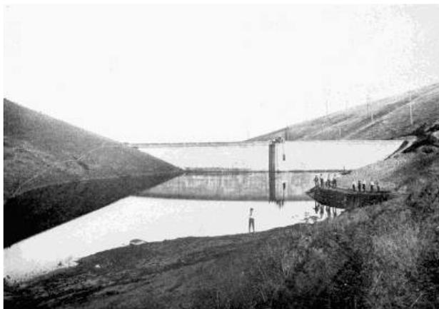
**ONE VIEW OF THE PARTIALLY COMPLETED TWENTY MILLION GALLON POMEROY GULCH RESERVOIR. A LINK IN THE PRESSURE WATER SERVICE FOR THE IRRIGATION**
