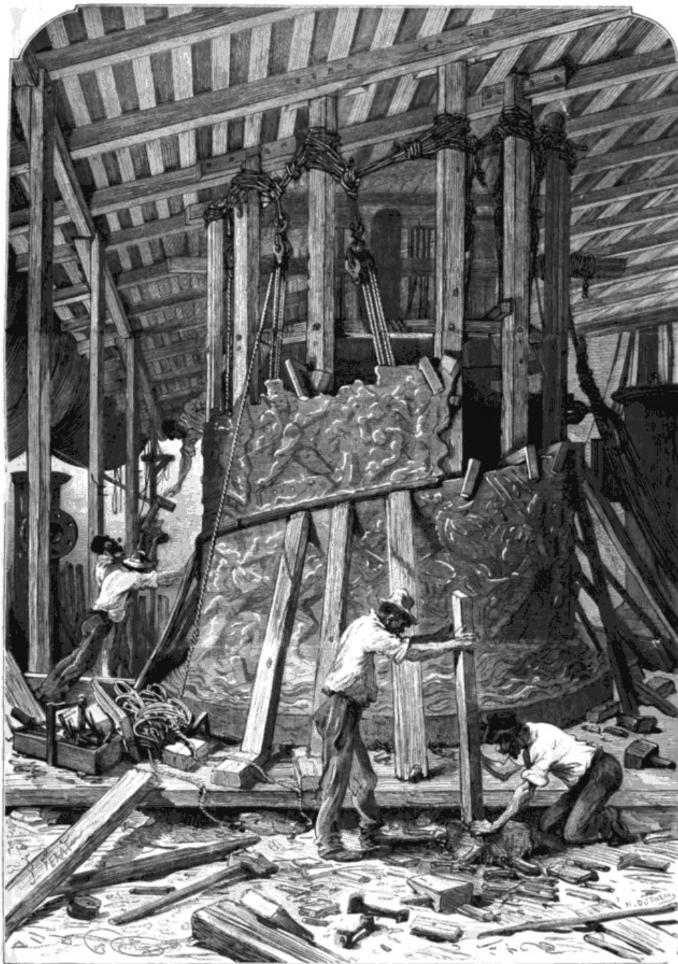
LA RECONSTRUCTION DE LA COLONNE VENDÔME.--L'ajustage des pièces.
