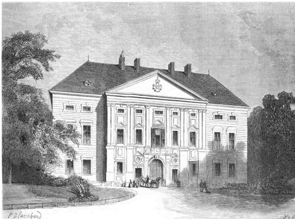
LE CHÂTEAU DE FROHSDORFF.--Vue prise du côté de la façade principale.--D'après le croquis de notre correspondant M. Petrovits.
