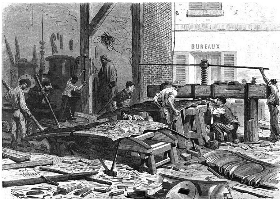
LA RECONSTRUCTION DE LA COLONNE VENDÔME. --Redressage des pièces de la colonne dans l'usine de MM. Monduit et Béchet.
