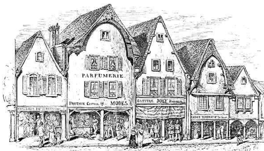
RUE DE L'ETAPE, REIMS.
