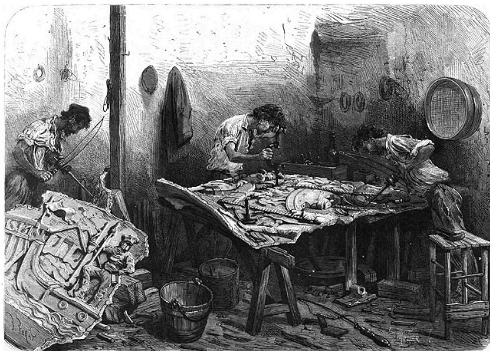
LA RECONSTRUCTION DE LA COLONNE VENDOME.--Restauration artistique des pièces de la colonne dans l'usine de M. Thiébault.
