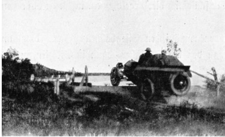
Übergang über eine alte Holzbrücke auf der verlassenen sibirischen Straße.
