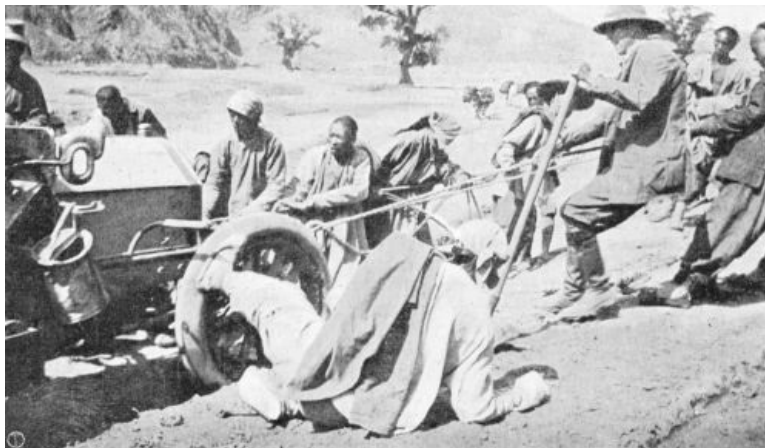
Manöver zum Freimachen eines in eine tiefe Spalte geratenen Vorderrades.
