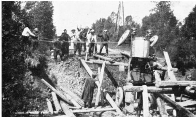
Freimachung von den Brückenresten.
