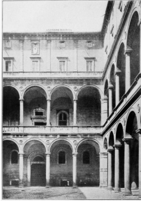
PALAZZO DELLA CANCELLARIA, ROME COURTYARD.
