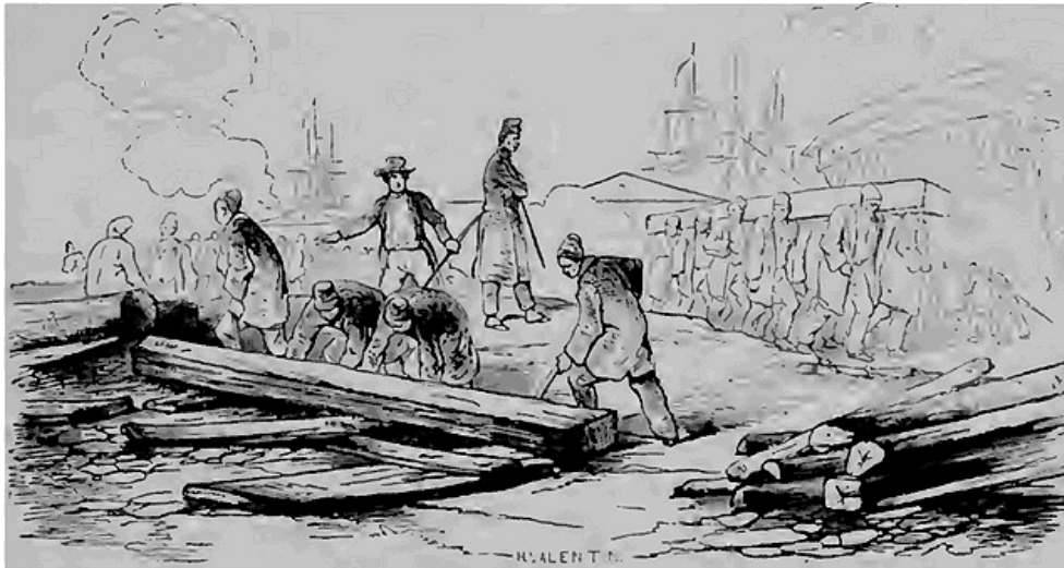
Travaux des Forçats.
