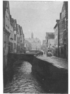
RUE BASSE DES TANNEURS In background, Hôtel Morgan and old Château d'Eau .
