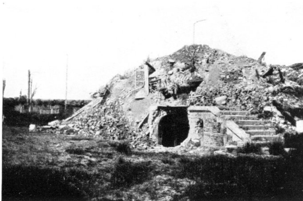
CONTALMAISON. ENTRANCE TO THE CHÂTEAU.
