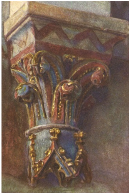
Romanisches Dienstkaptäl des Mittelschiffes mit später angesetzttem gotischen Baldachin.
