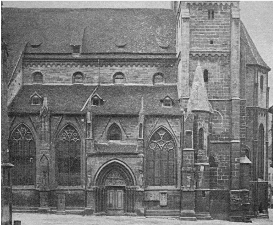
Abb. 38. Nördliches Seitenschiff vor der Restaurierung.
