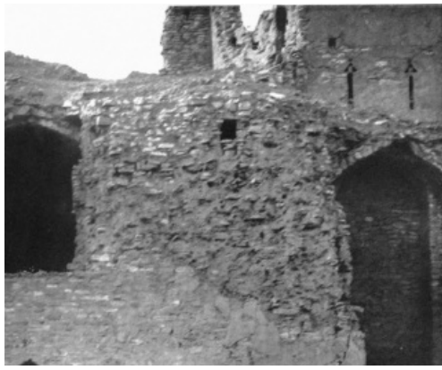
FIG. 2. Ukhaïdir, north façade, showing loopholes of chemin de ronde.
