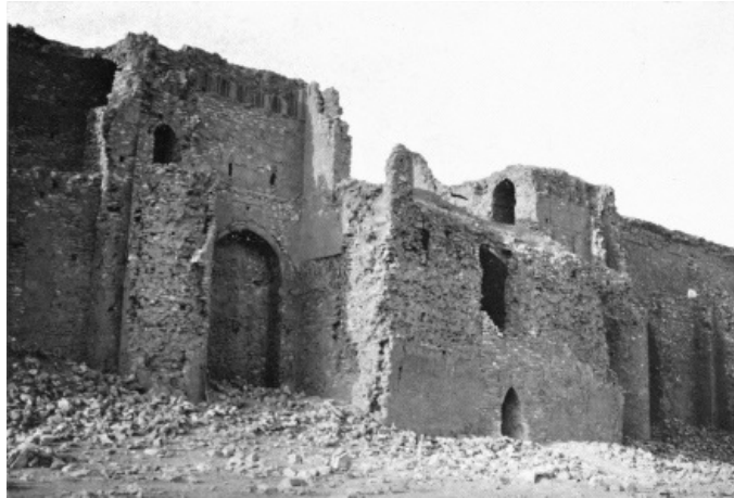
FIG. 1. Ukhaïdir, north façade.
